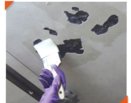
預防/修補室內牆身及天花板滲漏
